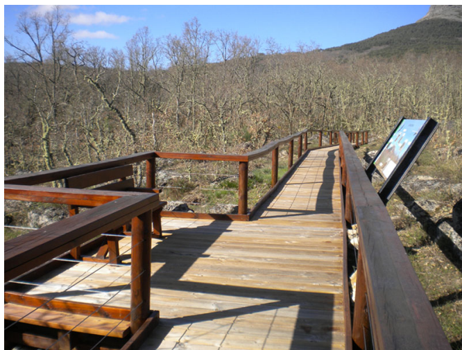
Pasarela de madera del sendero
